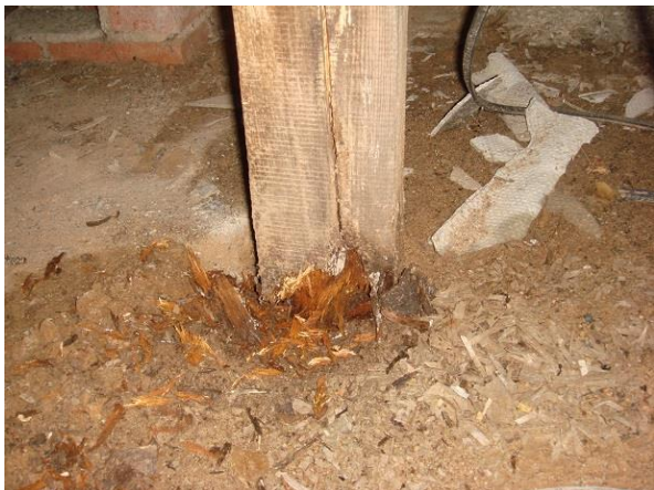
4.8-5 (Trupe statā balstījumā uz pārseguma. Zem bojājuma jumta segumā)
