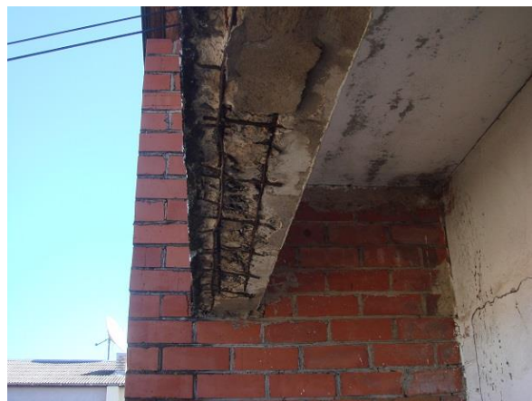
4.4.-2 (Sienu panelis virs lodžijām, apakšējās daļas izdrupumi)
