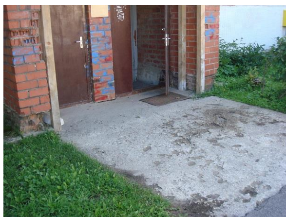
4.9-6 (Ieejas lieveņi bez pakāpieniem, 5.sekcija. Grīda vējtverī nosēdusies.)
