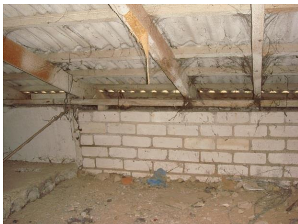
4.8-1(Mūrlatas balstījums uz sienas paneļa bez hidroizolācijas. Mūrlatas nav enkurotas)
